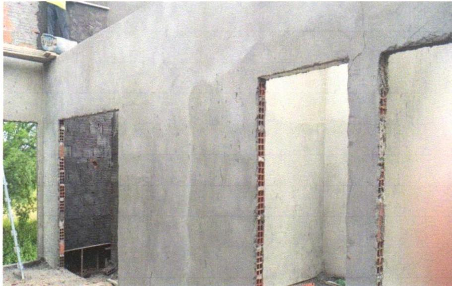
**Foto 07** – MASSA ÚNICA, PARA RECEBIMENTO DE PINTURA, EM ARGAMASSA TRAÇO 1:2:8, PREPARO MANUAL, APLICADA MANUALMENTE EM FACES INTERNAS DE PAREDES, ESPESSURA DE 10MM, COM EXECUÇÃO DE TALISCAS. AF\_06/2014
