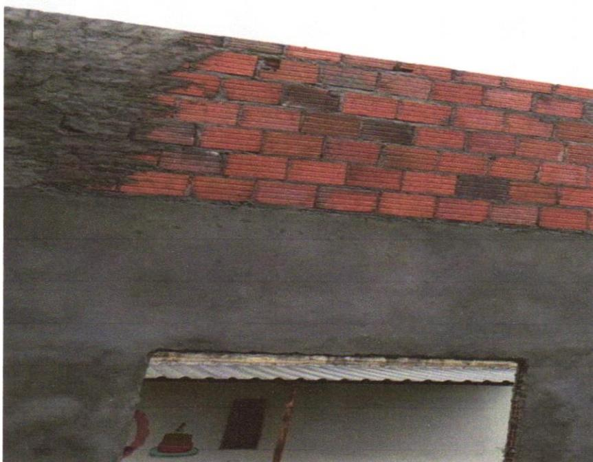
**FOTO 05** – CHAPISCO APLICADO EM ALVENARIAS E ESTRUTURAS DE CONCRETO INTERNAS, COM COLHER DE PEDREIRO. ARGAMASSA TRAÇO 1:3 COM PREPARO EM BETONEIRA 400L. AF\_06/2014
