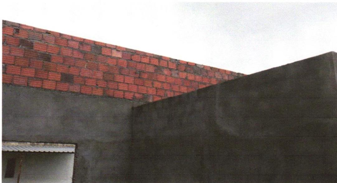
**FOTO 01** – ALVENARIA DE VEDAÇÃO DE BLOCOS CERÂMICOS FURADOS NA VERTICAL DE 9X19X39CM (ESPESSURA 9CM) DE PAREDES COM ÁREA LÍQUIDA MAIOR OU IGUAL A 6M<sup>2</sup> COM VÃOS E ARGAMASSA DE ASSENTAMENTO COM PREPARO EM BETONEIRA. AF\_06/2014
