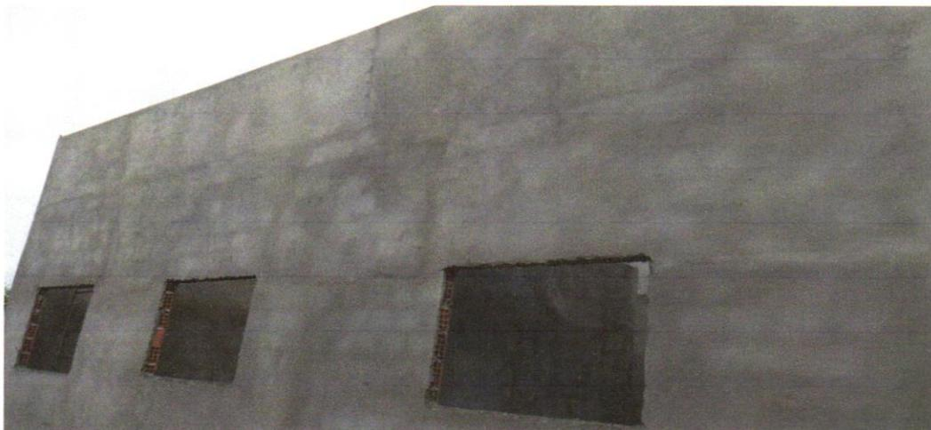
**FOTO 03** - MASSA ÚNICA, PARA RECEBIMENTO DE PINTURA, EM ARGAMASSA TRAÇO 1:2:8, PREPARO MANUAL, APLICADA MANUALMENTE EM FACES INTERNAS DE PAREDES, ESPESSURA DE 10MM, COM EXECUÇÃO DE TALISCAS. AF\_06/2014
